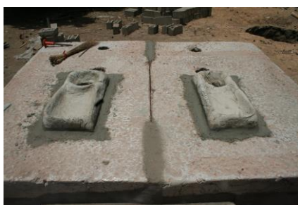
Les dalles à diversion posées sur les dalles de fermeture, le deuxième raccord pour l'évacuation des urines, le coffrage pour le joint du tuyau des eaux de lavements
