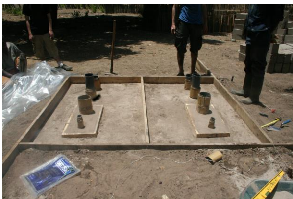
Le coffrage des dalles de recouvrement et la pose du treillis dans la deuxième dalle
