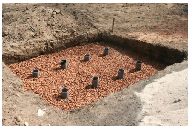
Le décaissement et le hérisson avant la pose du coffrage
