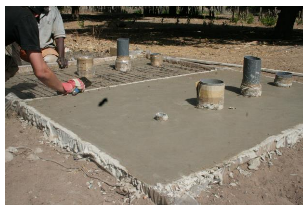
Le coffrage des dalles de recouvrement et la pose du treillis dans la deuxième dalle
