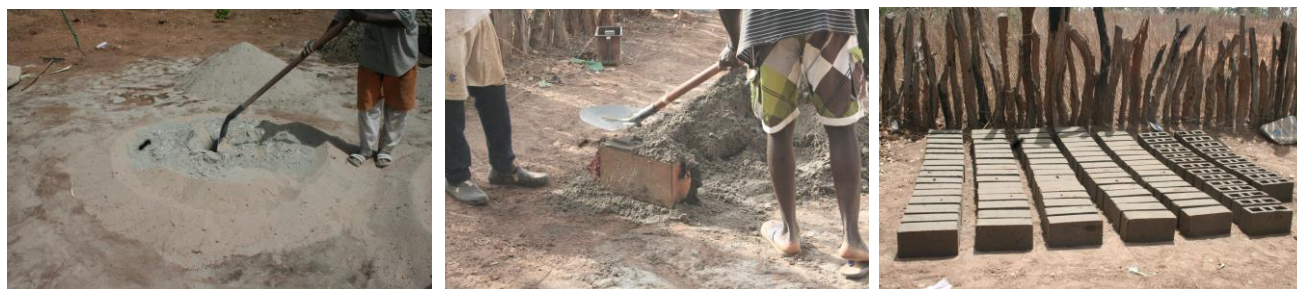
Le mélange du ciment et du sable, le remplissage des moules et les briques démoulées
