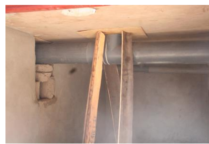
Les dalles à diversion posées sur les dalles de fermeture, le deuxième raccord pour l'évacuation des urines, le coffrage pour le joint du tuyau des eaux de lavements
