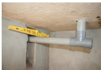
Les dalles à diversion posées sur les dalles de fermeture, le deuxième raccord pour l'évacuation des urines, le coffrage pour le joint du tuyau des eaux de lavements
