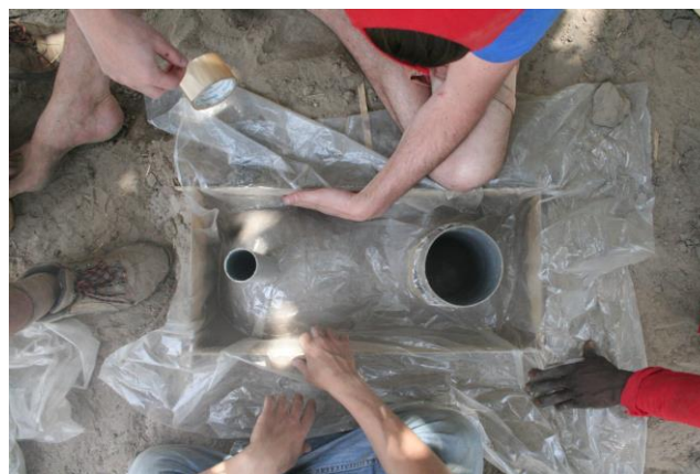
Le moule réalisé dans le sol en sable et contreplaqué et la pose du film d'étanchéité
