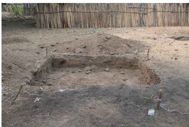
Le décaissement et le hérisson avant la pose du coffrage
